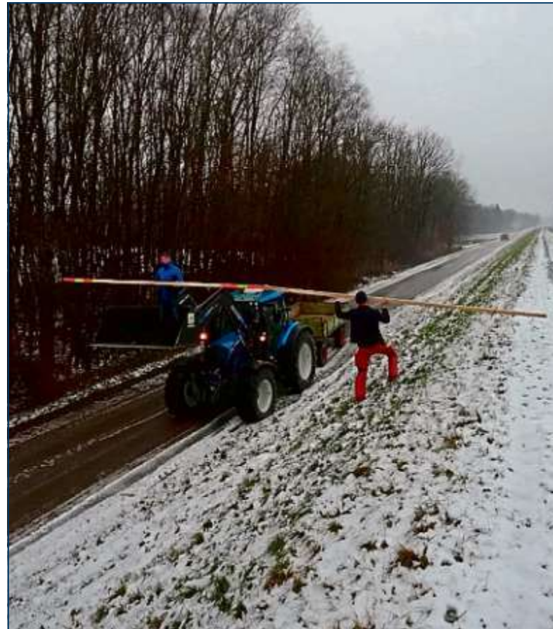
Die Querlatte zeigt die mittlere Einstauungshöhe von 3,63 Metern, sprich, den Wasserpegel bei Flutung.
