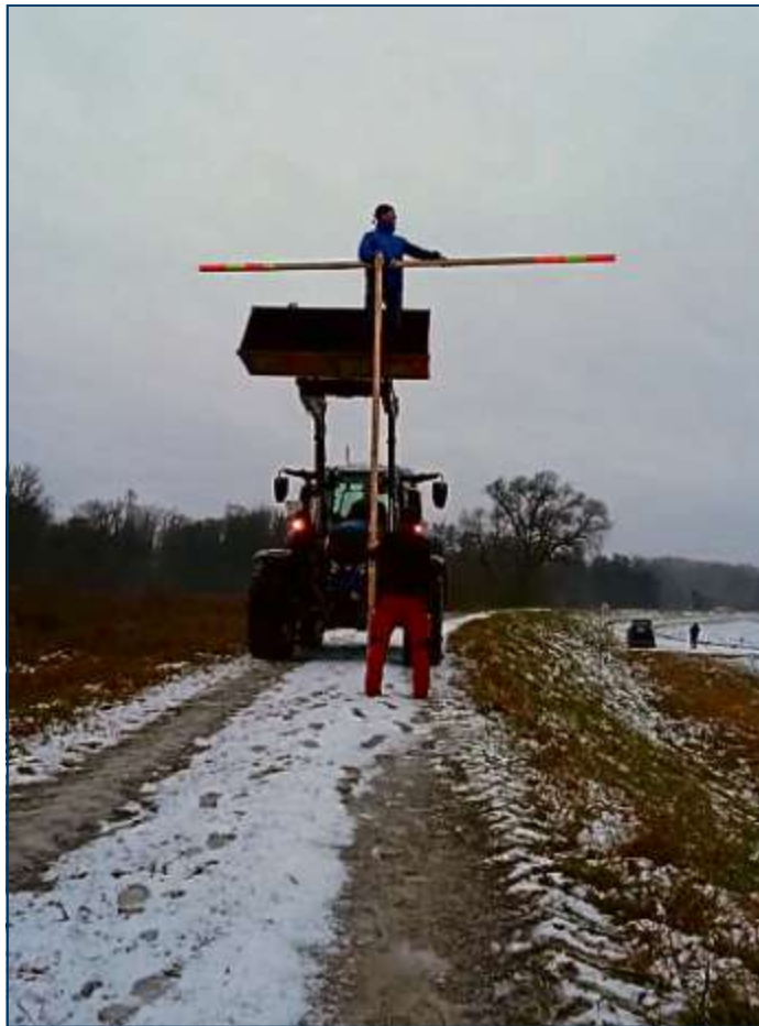
Die Querlatte zeigt die geplante Dammerhöhung auf 5,13 Meter.
