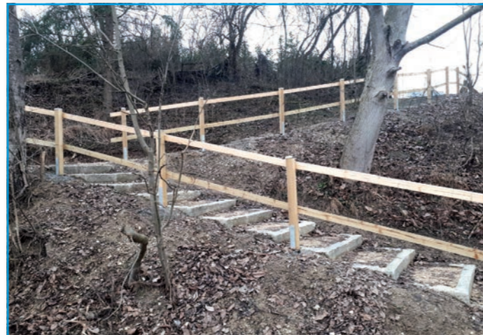
Der frühere und zwischenzeitlich vergessene Trampelpfad, ausgehend von „Ringstr.“ und „Am Hang“ Richtung Regenrückhaltebecken „Am Hanggarten“, wurde vom gemeindlichen Bauhof vor kurzer Zeit wieder ertüchtigt und erstrahlt im neuen Glanz. Auch die vormals sehr steile und schwer zugängliche Anbindung zum Gemeindviertel „Großmehring Ost II“ wurde so gestaltet, dass sie bequem genutzt werden kann.
